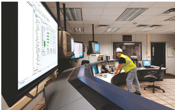
Präventive Instandhaltung von Regelventilen: Vollautomatisches Diagnosesystem ValveSight meldet Auffälligkeiten noch bevor Symptome auftreten. (Alle Bilder: Flowserve Essen GmbH, Essen)
