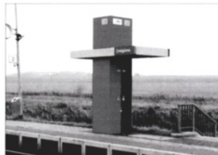
Verkehrsstation Övelgünne zwischen Eilsleben und Magdeburg wurde mit Mini-DB PlusPoint ausgestattet
