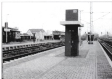
Mit DB PlusPunkten zu mehr Komfort auf dem Bahnhof Eilsleben (Foto: Neumann Elektronik)
