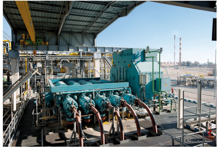
Hyper-Kompressor zur LDPE-Produktion (Quelle: Burckhardt Compression AG)
