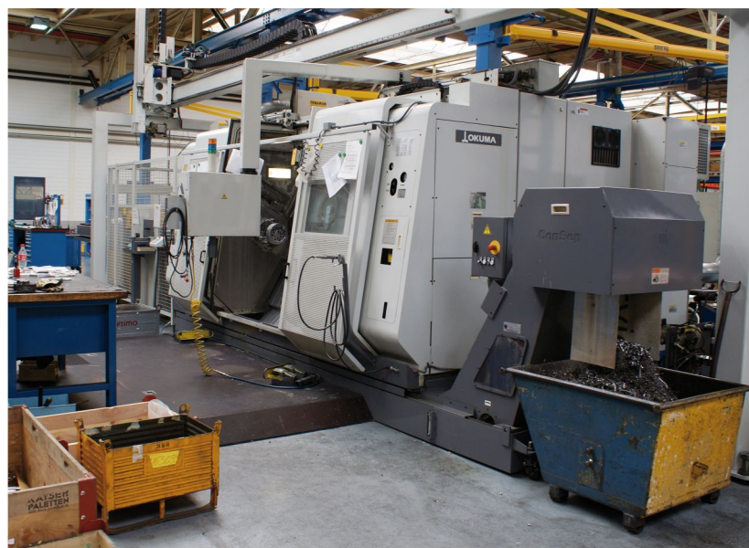
Eines von mehreren CNC-Drehzentren mit und ohne Subspindel (Quelle: give4pr, Essen)
