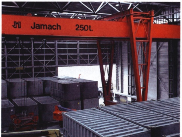
3 Ermittlung exakter Positionen mit APOS und kurze Verfahwege steigern die Umschlaghäufigkeit (Fotos: FAB A 2, Give)
