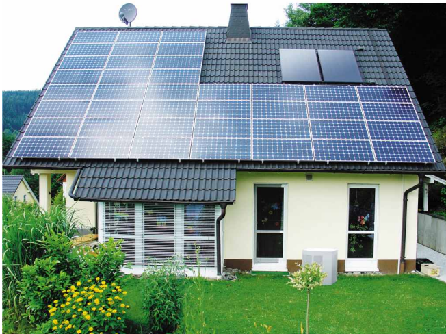
Nutzung der Sonnenenergie mit einer 80 kW-Anlage kombiniert mit einem Außenluftmodul (Quelle: SunTechnics GmbH, Hamburg)
